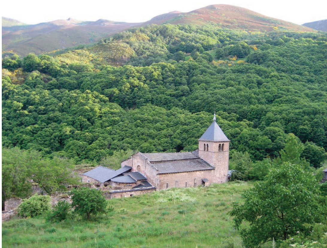
Mosteiro de San Pedro de Montes
